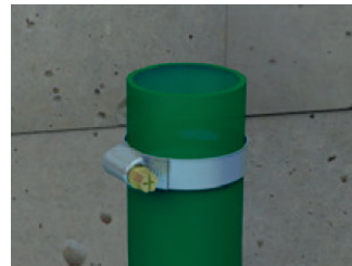
1. Coloque la abrazadera.
